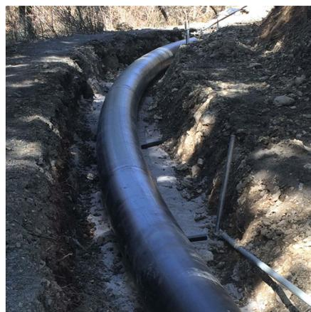
Fig. 4 PE 管の生曲げ
