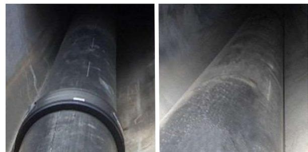
Fig. 8 配管完了後のPE管
